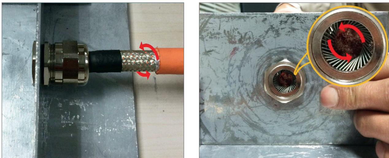
4.3. На фото ниже пример правильно расположенной экранирующей пружины
